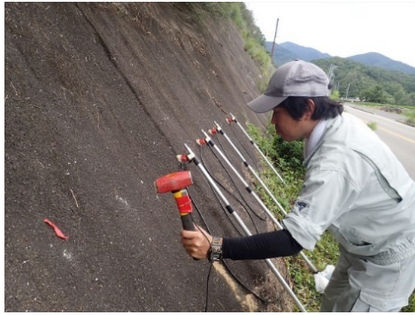
写真-2 モルタル吹付面での測定状況
