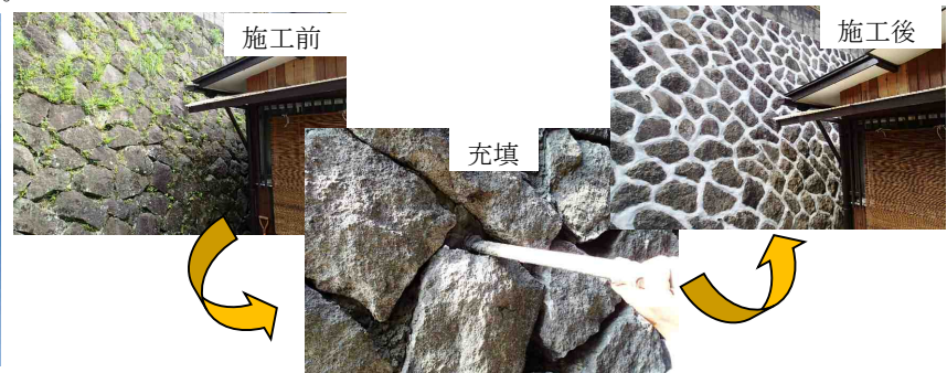
図2 石積接着補強工法の施工状況
