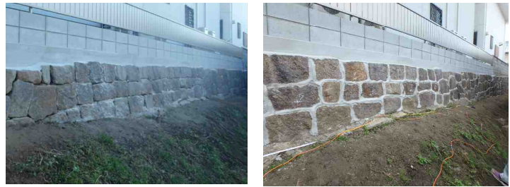
図4 実験対象の空石積擁壁（左：石積接着補強工法施工前、右：施工後）
