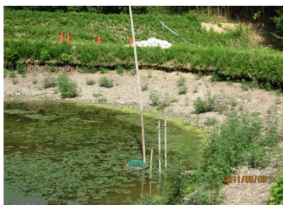
写真 4.3.1 浸透破壊したため池
