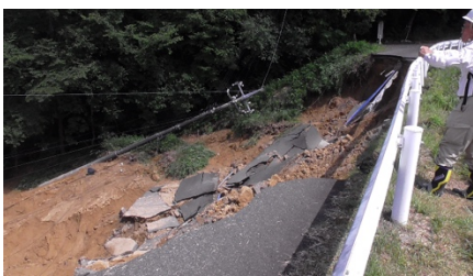
写真 4.1.1 堤体崩落（冠光寺池）
