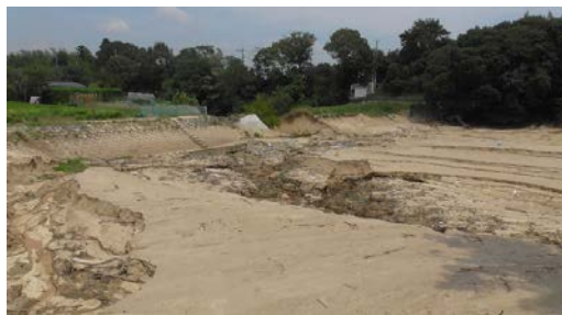
写真 4.2.6 土石流で埋まったため池 横池（東広島市） （平成 30 年 7 月豪雨）
