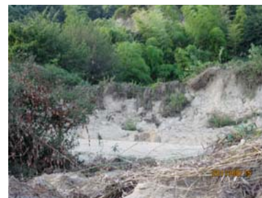
写真 4.2.3 越流による下流法面の侵食（下流側から望む） 岡山市東区宝伝のため池 （平成 23 年台風 12 号）
