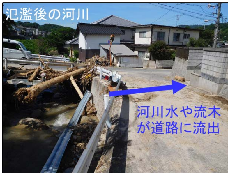
写真2.10-1 平成30年7月豪雨における橋梁下の流木による閉塞とそれに伴う土砂洪水氾濫
