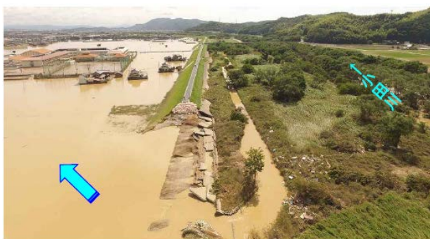
図3.5-1 小田川KP3.4での破堤状況 1)
