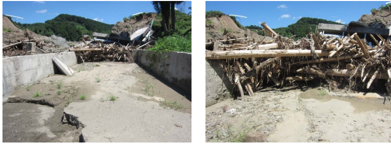
写真 4.2.4 流木で閉塞された洪水吐 山の神ため池（朝倉市） （平成 29 年 7 月九州北部豪雨）
