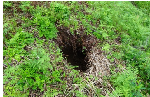
写真4.5.2 漏水によって堤体に空洞が生じた事例
