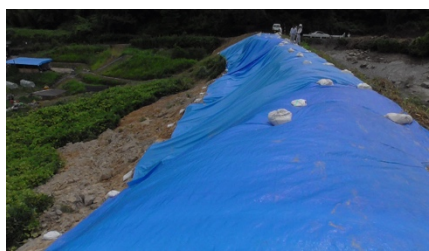
写真 4.1.2 堤体崩落（江田池）
