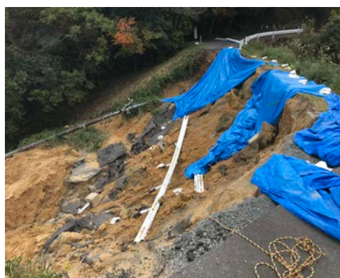
写真 4.6.1 池周辺道路からの出水による堤体の侵食
