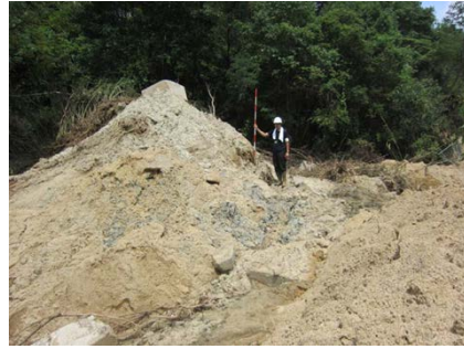
写真 4.1.5 堤体の破堤（勝負迫上池）
