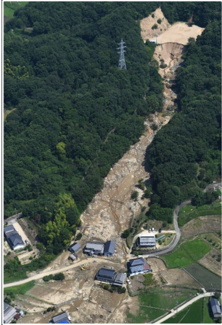
写真 4.1.4 勝負迫池（広島県福山市）の破堤現場 （毎日新聞，2018/7/16）
