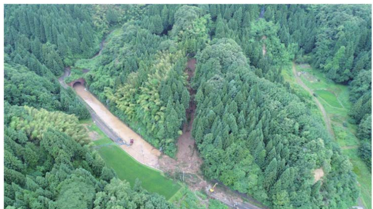
写真2.3-2 崩壊土砂がトンネル内に流入している状況 5)
