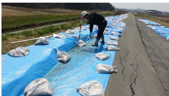
写真3.3-1 天端川表側に開口亀裂発生
