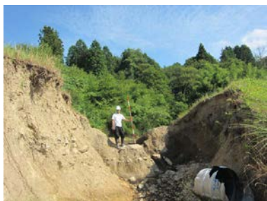
写真 4.2.1 越流によるため池の破堤 寺田池（東広島市） （平成 30 年 7 月豪雨）
