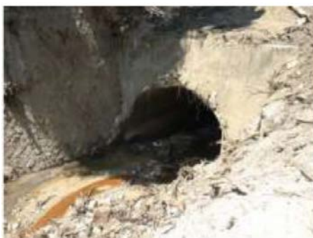
写真2.3-1 道路横断管の閉塞状況 4)
