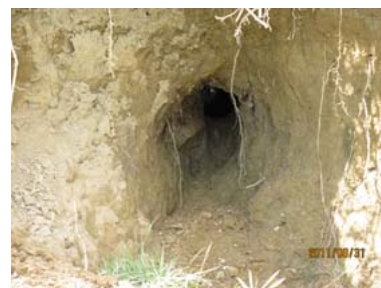
写真 4.3.3 浸透破壊を起こした穴
