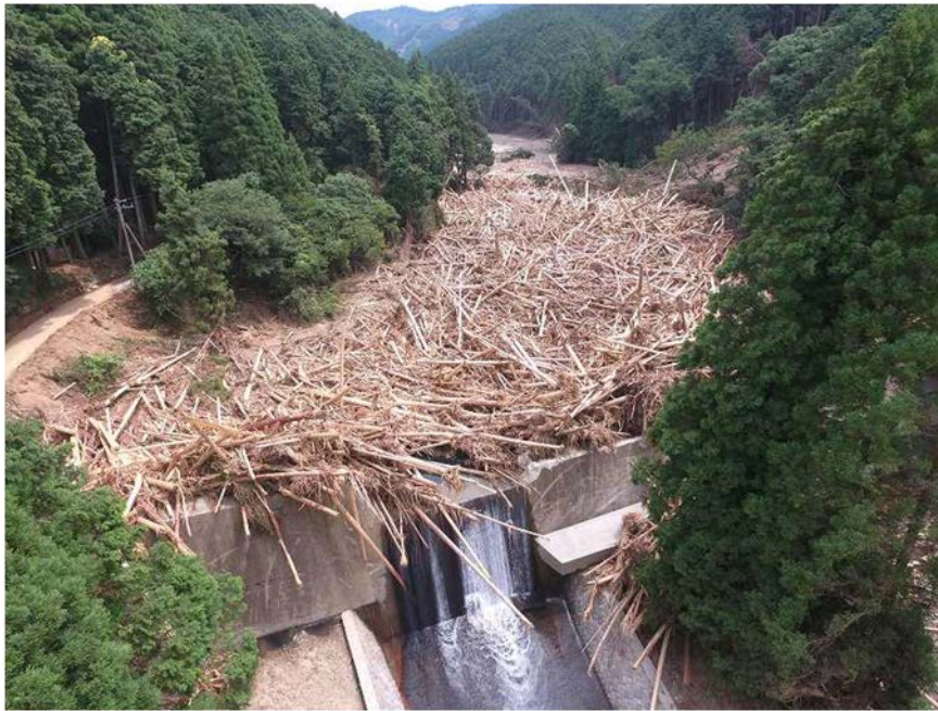
図2.10-2 平成29年九州北部豪雨における妙見川（須川第1砂防堰堤）での流木の状況
