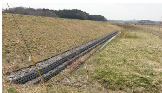
写真3.3-2 川裏側には変状なし
