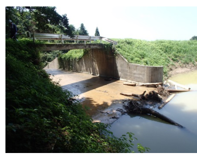
写真 4.4.3 閉塞されなかった洪水吐 (平成 29 年 7 月九州北部豪雨)
