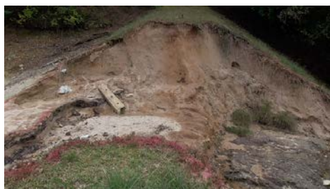
写真 4.2.2 越流によるため池の破堤断面 向迫田ため池（山県郡北広島町） （平成 30 年 7 月豪雨）
