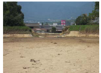
写真 4.2.7 土石流で埋まった ため池 大池（東広島市） （平成 30 年 7 月豪雨）
