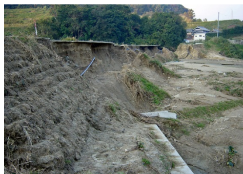
写真 4.6.2 越流による堤体の侵食
