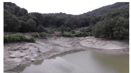
写真 4.1.3 堤内に流入した土砂（江田池）
