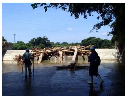
写真 4.4.2 洪水吐越流堤と流木の状況 (平成 29 年 7 月九州北部豪雨)
