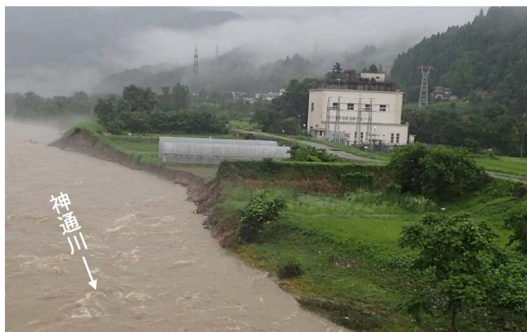
図3.5-4 神通川での側方侵食による堤防欠損 3)
