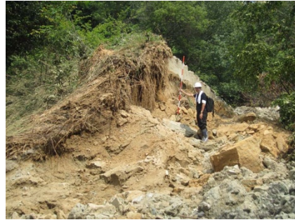
写真 4.1.6 堤体の破堤（勝負迫下池）
