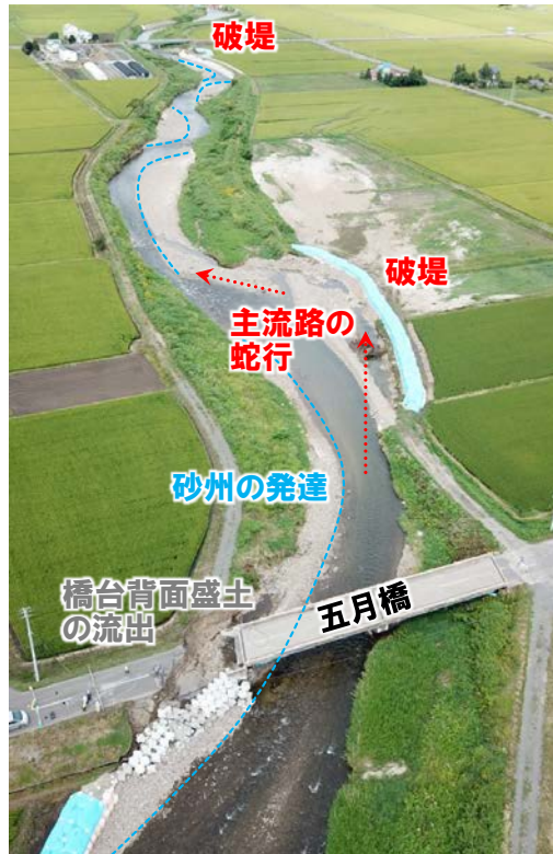
図3.5-3 倉沼川での流路蛇行に伴う河岸侵食と破堤
