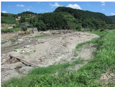
写真 4.2.5 土石流で埋まった ため池 山の神ため池（朝倉市） （平成 29 年 7 月九州北部豪雨）
