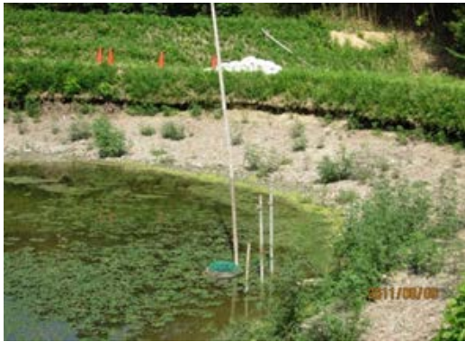
写真4.5.1 上流側法面が浸食した事例
