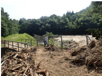
写真 4.4.1 洪水吐の閉塞状況 (平成 30 年 7 月豪雨)
