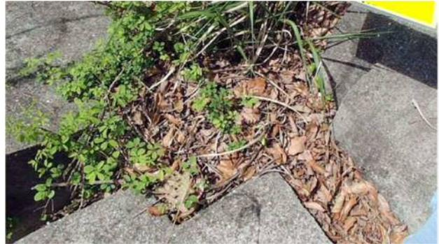
写真 3 完全に閉塞した法面小段水路工
