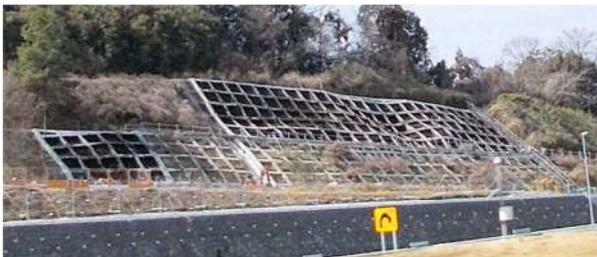
写真 2 閉塞・溢水で崩壊した法面の事後対策例
