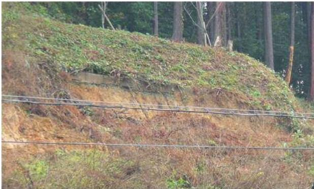
写真 1 水路工の閉塞・溢水により崩壊した法面
