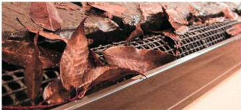
写真 4 雨樋の枯れ葉よけネットの例
